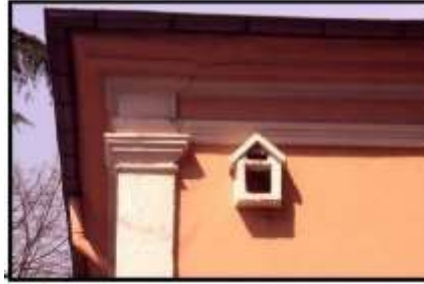
شكل رقم (١٠) إستانبول - سراي إسحاق باشا (١٠٩٥-١٠٩٦ هـ/١٦٨٤-١٦٨٥ م) - الواجهة الجنوبية
