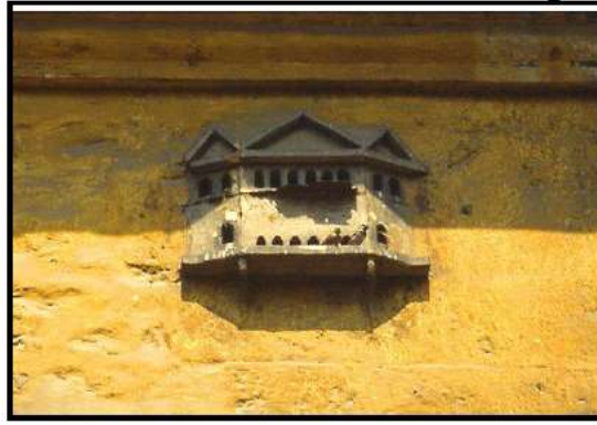
شكل (٢٦) إستانبول - قصر توبكابي - مبنى يشرف على فناء النعناع ق (١٣ هـ / ١٩ م) - الواجهة الشرقية
