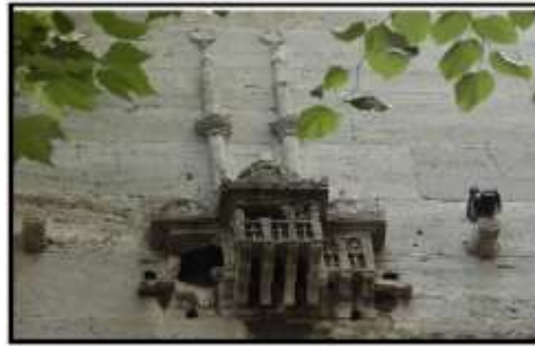
شكل رقم (٢٩) إسكيدار - جامع الوالدة الجديد (١٠٠٥-١٠١١ هـ / ١٥٩٧-١٦٠٣ م)، (١٠٧١-١٠٧٣ هـ / ١٦٦١-١٦٦٣ م) الواجهة الشمالية الشرقية
