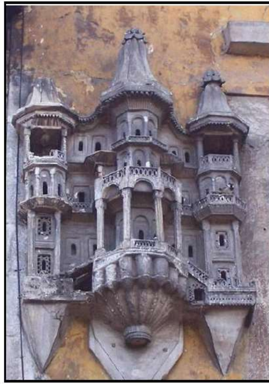
شكل رقم (٢٧) - إستانبول - قصر توكباي - مبنى الجناح الإمبراطوري - ق (١٢ هـ / ١٨ م) - الواجهة الشمالية.
